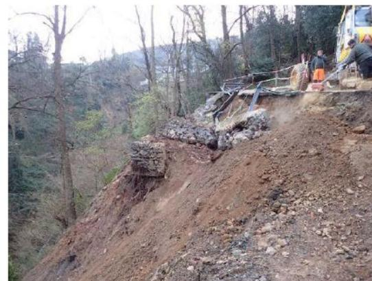
**Fig. 8:** 15.3.2024, demolizione controllata gabbioni
