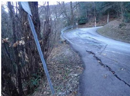
**Fig. 1:** cedimenti e lacerazione del manto stradale
