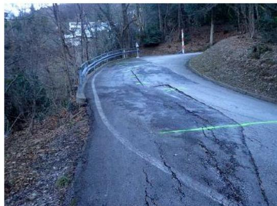
**Fig. 2:** cedimenti e lacerazione del manto stradale
